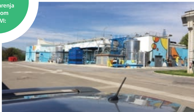
SLIKA 2 Uređaj za obradu otpadnih voda na lokaciji SM - WWTP uređaj
