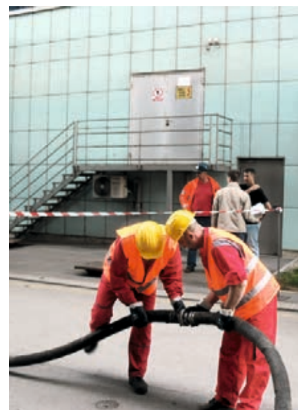
Slika 3. Čišćenje taložnice putem ovlaštene i ugovorne tvrtke na lokaciji Prilaz baruna Filipovića
